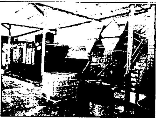
Foto 9. Planta de tratamiento de aguas residuales.
